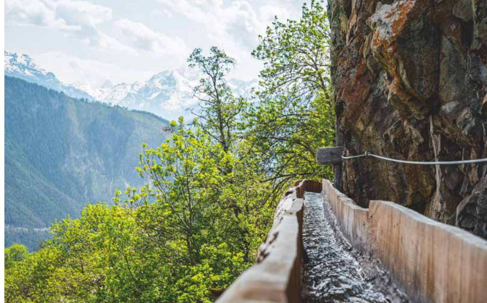
Ve Wallisu je přes 600 vysokohorských závlahových kanálů. S nasazením života horalové zavěšovali na skály dlouhé vydlabané kmeny, jimiž pak proudila voda. Tento zrekonstruovaný dřevěný kanál vede podél strmé stěny nad vesničkou Mund. FOTO: ANDRÉ MEIER
