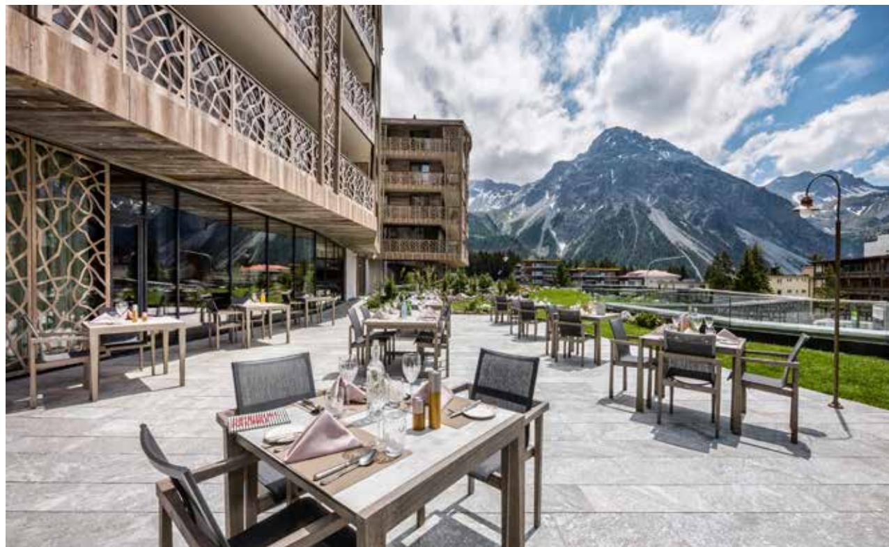
Při stavbě hotelu Valsana na kraji Arosy, který je díky energetické koncepci průkopníkem v ekologii, architekti využili recyklované materiály ze staré budovy.
